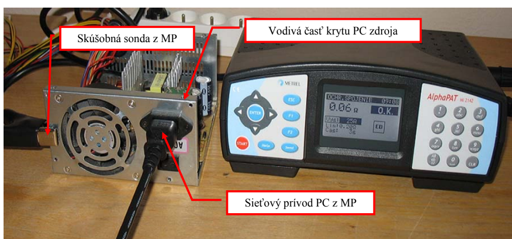
Obr. 11 Príklad merania odporu ochranného vodiča R_{PE} na spotrebiči/PC zdroji meracím prístrojom AlphaPAT MI 2142 METREL
